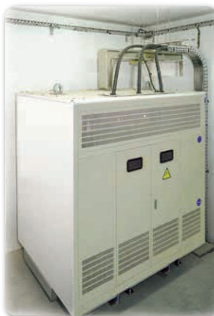
带 IP21 外壳的低压封闭母线连接
