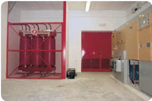
安装在变电室的 IP00 变压器
