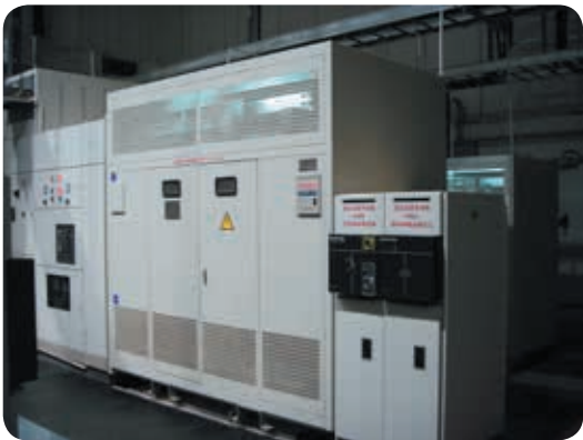
装在电子厂现场的 IP31 变压器
